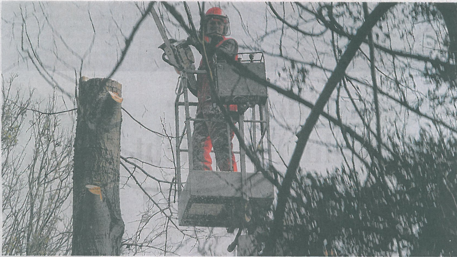
Fällt man in Linz zu schnell Bäume? Nach einer Phase der Verständigung im vergangenen Sommer sind Baumschützer nun wieder misstrauisch. Foto: Weibold
